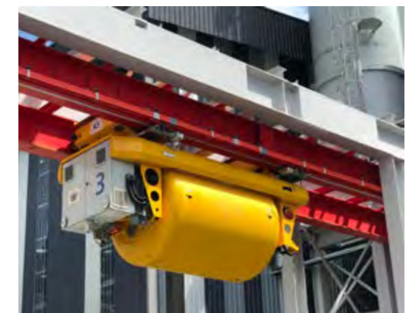
Automatischer Transport der Kübelbahn. Automatic Concrete Transport by Flying Bucket.
