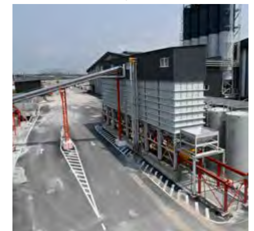
Beschickung der Zuschlagstoffsilos. Material Loading into Aggregate Bins.
