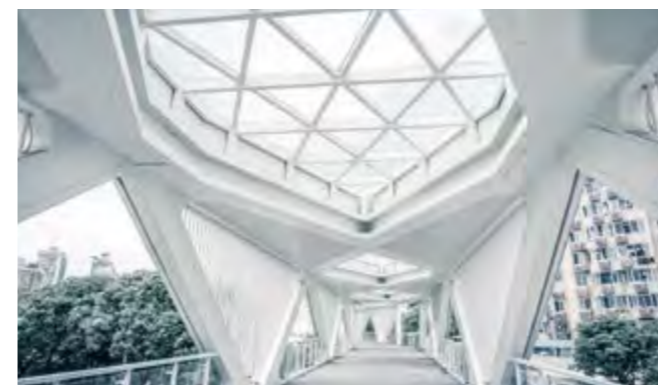
UHPC für materialsparende und leichte Konstruktionen. UHPC for material-saving and slim structures.
